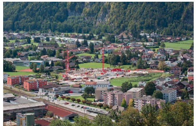
Blick auf den Bauplatz in Näfels.
